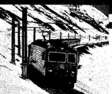
Fahrleitungen für Bahn und Trolleybus
