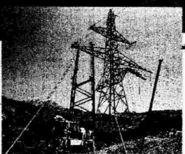
Freileitungs- und Kabelbau
